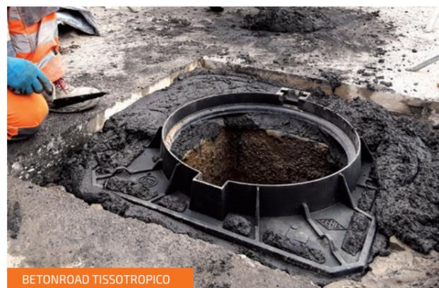
Completare prontamente il **riempimento esterno del telaio** con BetonRoad in **consistenza tissotropica** con cazzuola, badile o secchio sino al piano finito/quota stradale.
