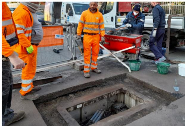
La **testa del pozzetto** deve essere **compatta, integra e pulita**: se necessario irruvidirla per migliorare la presa di BetonRoad. **Pulire la base superiore del pozzetto** (onde evitare la presenza di tracce di fango, grasso, detriti, etc.) e inumidirla evitando la formazione del velo d'acqua superficiale al fine di evitare la rapida asciugatura di BetonRoad in opera.
