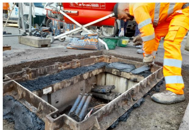
Eeguire prontamente il **rinfianco interno del telaio** con BetonRoad a **consistenza tissotropica** a mezzo cazzuola.
