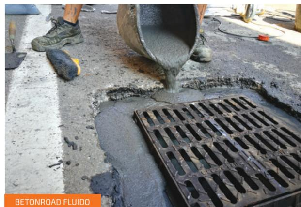
È possibile impiegare BetonRoad a **consistenza fluida** per impieghi meno prestazionali.
