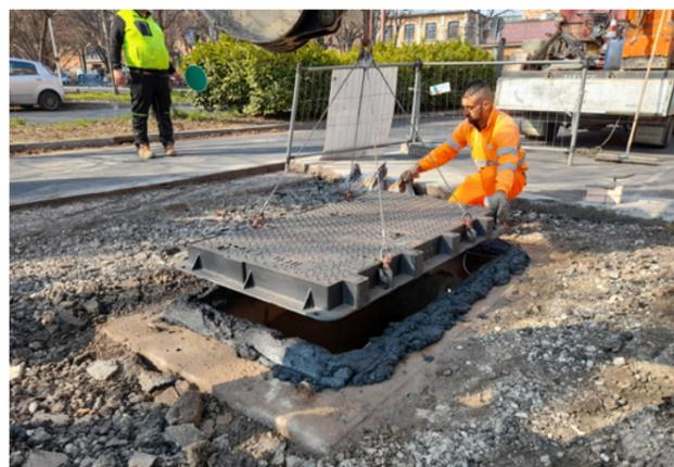
Posare il telaio del chiusino/caditoia esercitando un'adeguata pressione su BetonRoad in modo da "inghisare" il telaio al letto di posa assicurando una presa salda e un fissaggio perfetto (verificare che BetonRoad copra le flange del telaio con uno spessore minimo di 1 cm e fuoriesca lateralmente e dai fori/asole eventualmente presenti nel telaio stesso). Verificare la **complanarità del telaio con la quota stradale esistente**.
