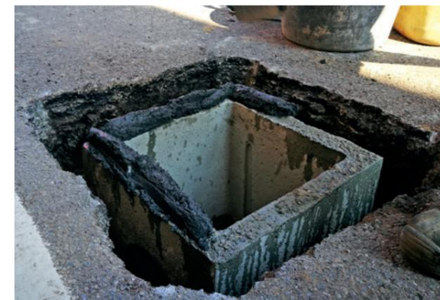
**Stendere uno strato di BetonRoad da 3 a 5 cm** circa con una cazzuola (a **consistenza tissotropica**) sull'**intero sviluppo della base superiore del pozzetto** e per **l'intera superficie del telaio** sino ad ottenere una superficie liscia e uniforme.
