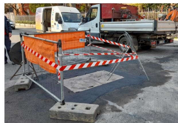
Attendere 2 ore ca. dal termine della posa di BetonRoad per la **riapertura al traffico gommato della strada** (per transiti veicolari pesanti anche 4-5 ore). Per accorciare i tempi di riapertura al traffico è possibile posare una **lastra di ferro** di adeguata robustezza e dimensione direttamente sul chiusino/caditoia dopo circa 1 ora dalla posa di BetonRoad.
