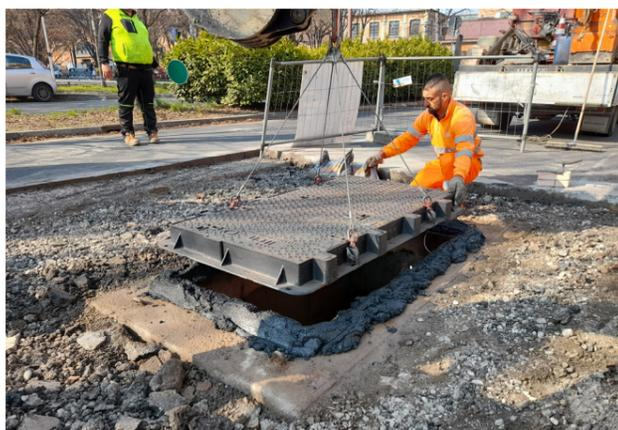
Posare il telaio del chiusino/caditoia esercitando un'adeguata pressione su BetonRoad in modo da "inghiassare" il telaio al letto di posa assicurando una presa salda e un fissaggio perfetto (verificare che BetonRoad copra le flange del telaio con uno spessore minimo di 1 cm e fuoriesca lateralmente e dai fori/asole eventualmente presenti nel telaio stesso). Verificare la **complanarità del telaio con la quota stradale esistente**.
