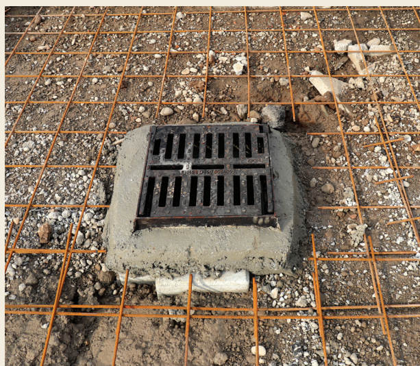
Fissaggio di pozzetti
