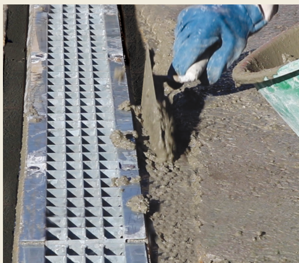
Fissaggio di canaline di scolo
