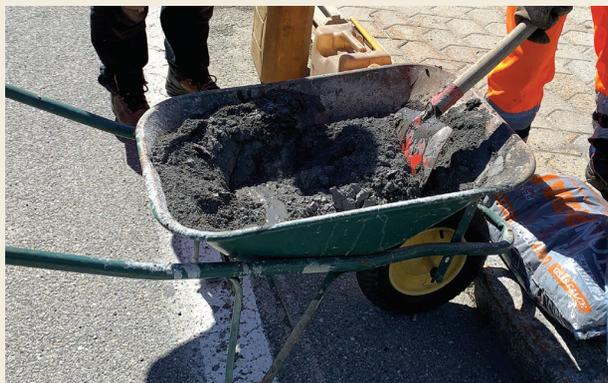
2A. Preparazione di BetonRoad con Turbomalt
