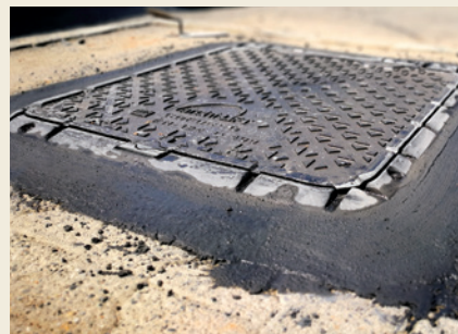
Riempimento esterno, lisciatura finale e posa del coperchio.
