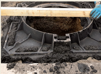
Posa del telaio, rinfianco interno ed esterno, messa in quota.
