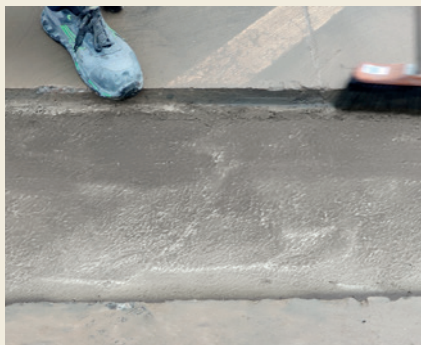
Preparazione del supporto e rimozione parte incoerente.
