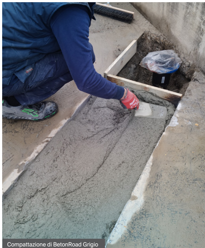
Compattazione di BetonRoad Grigio
