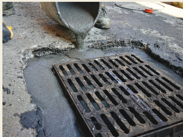
6B. Riempimento esterno con BetonRoad fluido
