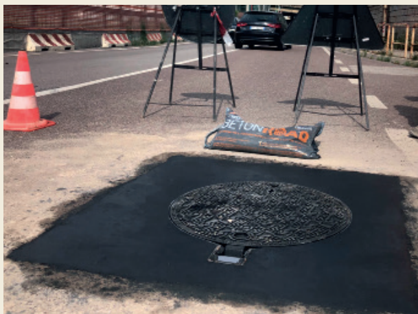
8. Posa del coperchio e apertura al traffico
