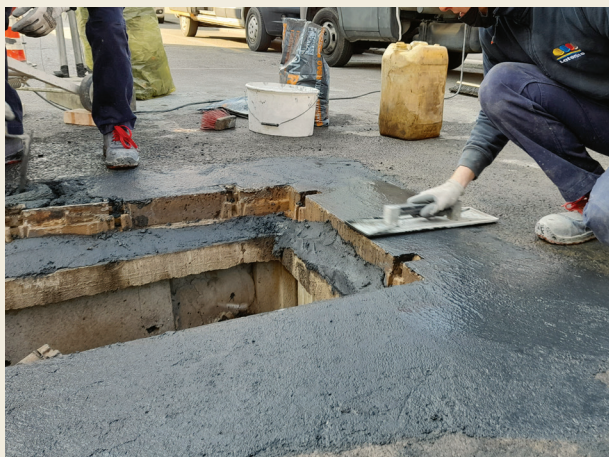
7. Finitura di BetonRoad
