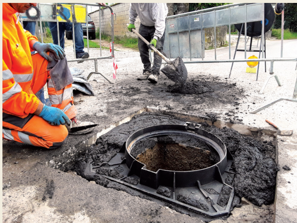
6A. Riempimento esterno con BetonRoad tissotropico
